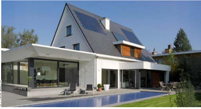
Ce système de tuiles solaires s'intègre parfaitement aux tuiles en ardoise grâce à la similitude de forme, la couleur anthracite et la fine épaisseur.
