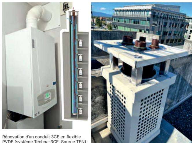
Rénovation d'un conduit 3CE en flexible PVDF (système Techna-3CE, Source TEN)
