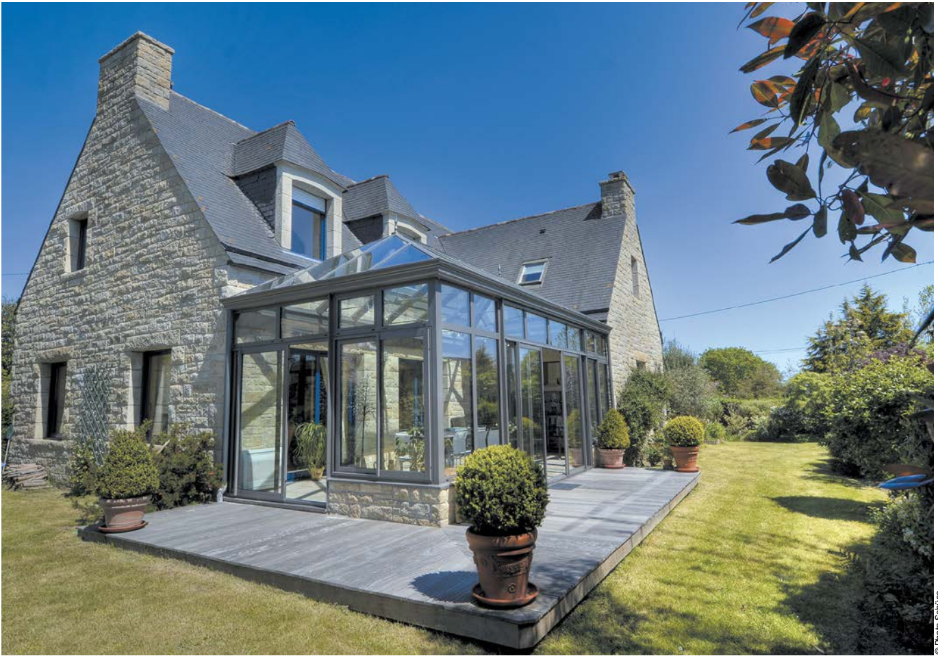
Comment une extension sait se faire oublier ! La structure en aluminium gris et le toit d'ardoises s'harmonisent à merveille.
